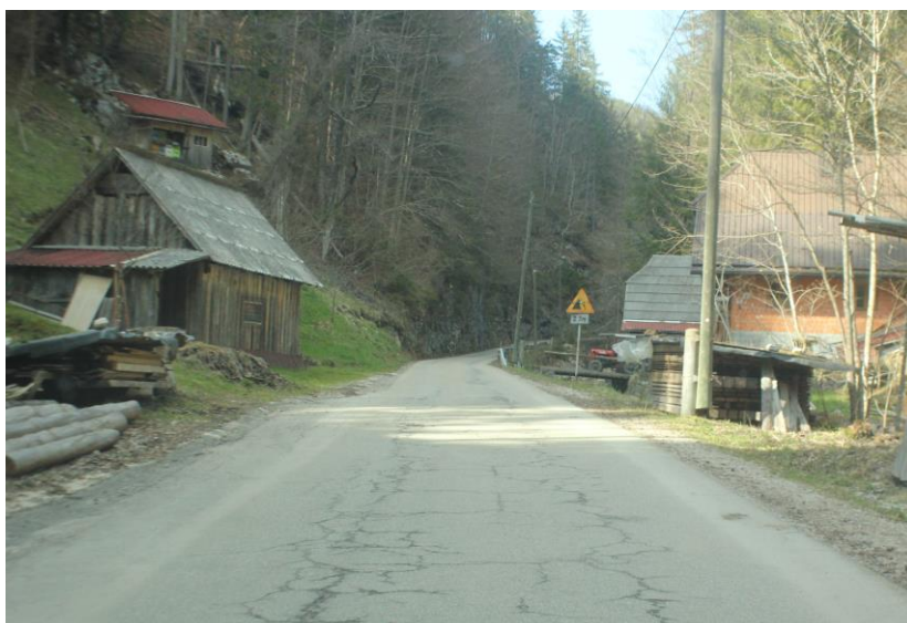
Slika 3 Pogled v območje profilov A6-A9, kjer je dotrajan mostiček, opornik ob desni obali se poruši in zamakne bolj proti cesti, nadomestni mostiček se nasloni na novi zid
