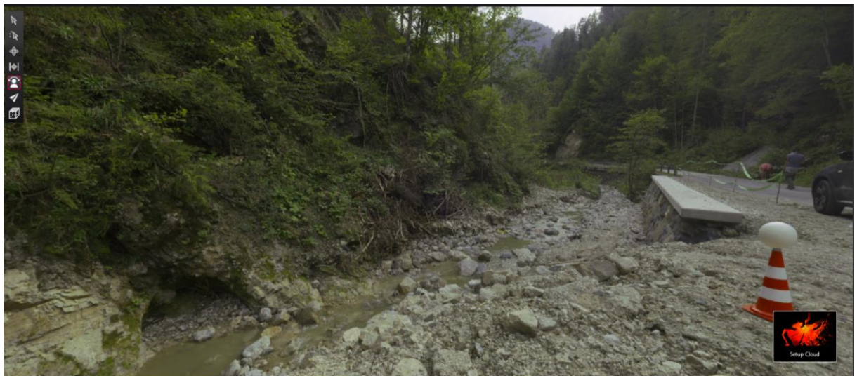
Slika 18. Pogled iz območja P28 dolvodno na novi zid
