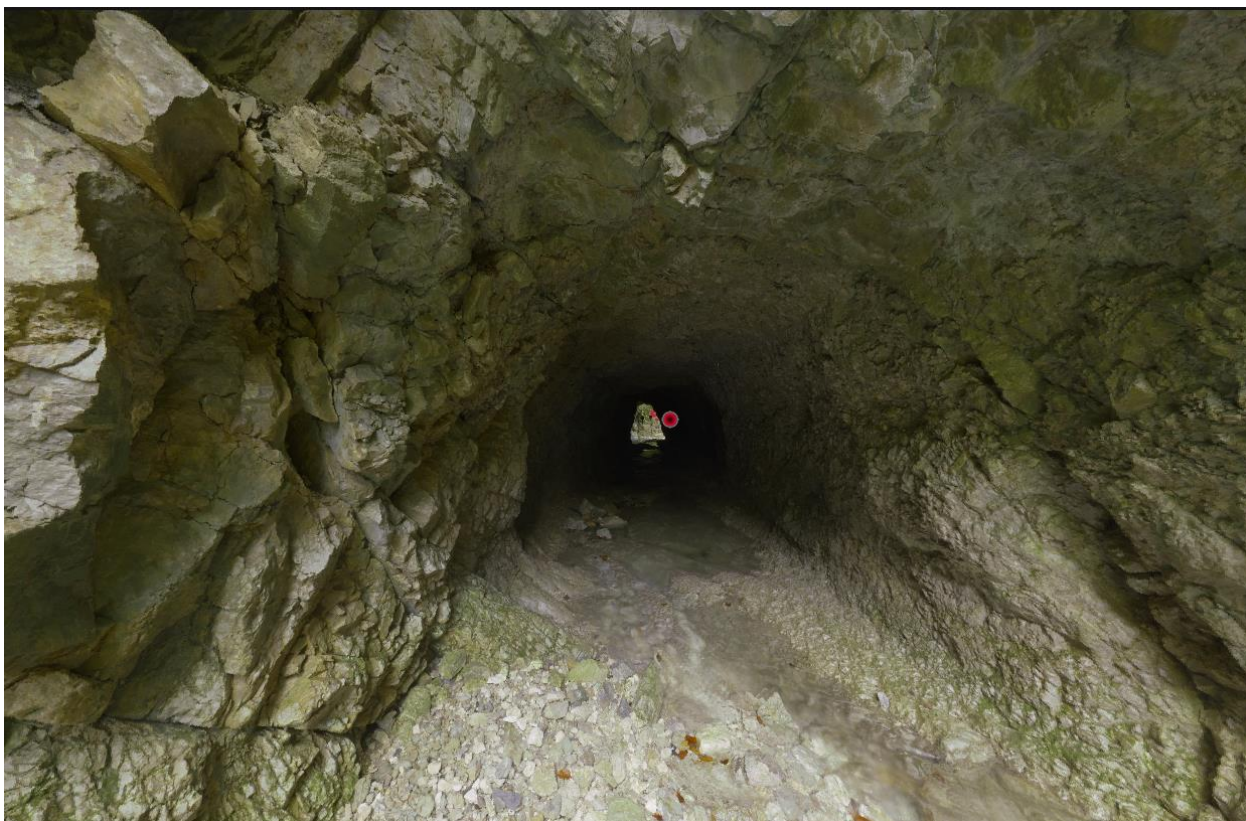
Slika 31. Pri prehodu skozi tunelski rov v katerem teče Helenskegi potok, vidno je da je hribina apnenca karniske stopnje stabilna, vidno je tudi, da imajo svoj vpliv erozijski procesi (obrus, zmrzal itd.) kateri pa njegovo stabilnost ne ogrožajo saj je temensko nadkritje dovolj masivno, erozija dna pa je celo koristna saj povečuje pretočnost. Po pričevanju domačinov prihaja gorvodno do zaježitve (cca 1m), vendar se posledično večja hitrost in staroselci vedo povedat, da ni bilo problema s pretočnostjo. Je pa v fazi del potrebno gorvodno očistiti-odstraniti podrta drevesa, kateri bi lahko vtok zaježili.
