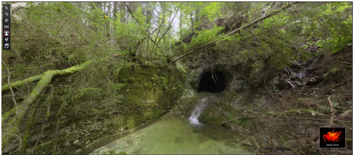
Slika 29. Pogled gorvodno iz P49 v 30m tunelski rov (najverjetneje je bil izveden v času rudarjenja)
