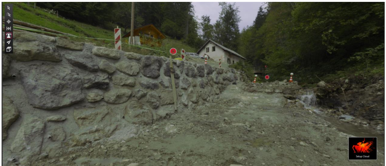
Slika 23. Pogled na izgrajen nadomestni kamniti zid v P37.
