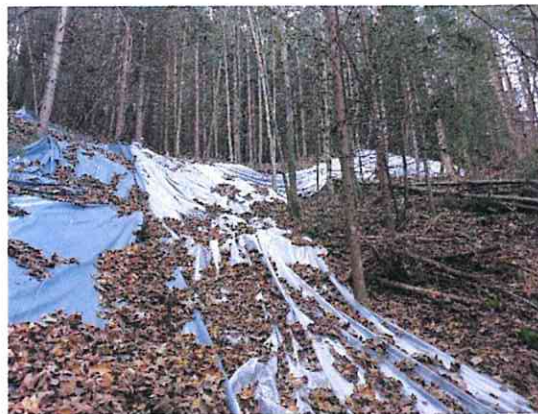
Fotografija 6: Pogled na naguban plazovit teren na gozdnem pobočju (12.10.2023)
