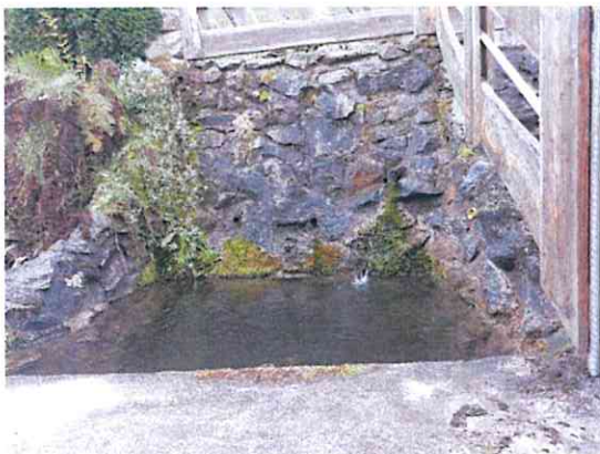
Fotografija 3: Stalen vodni vir precejne vode iz pobočja – ujet v betonsko korito (12.10.2023)
