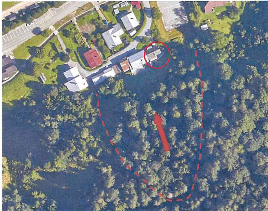
Slika 1: Pogled (DOF) na stanovanjski objekt Pristava 3 (označen z rdečim krogom) – rdeča črtkana črta prikazuje ocenjeno območje plazu
