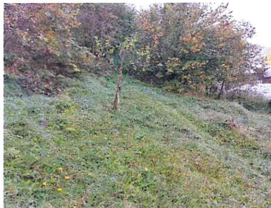
Fotografija 2: Pogled na zaledje stanovanjskega objekta, kjer morfologija terena in nagnjenost dreves nakazuje na aktivnost plazjenja (12.10.2023)
