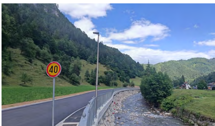
Obnova regionalne ceste Črna proti Pristavi.
