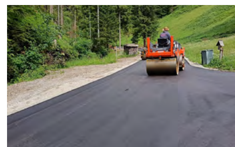
Sanacija ceste v Koprivno.
