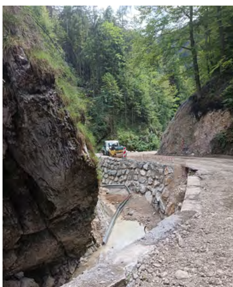
Poteka gradnja podpornih opornih zidov ter rekonstrukcija ceste v Podpeco.
