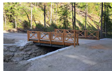
Postavljen je nov most na gozdni cesti Petelinjek.
