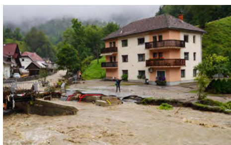
Pričela se je sanacija območja Center 2 in 4.
