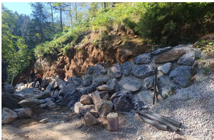
Sanacije lokalne ceste proti svetemu Jakobu v dolžini 1939 m.
