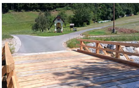
Obnova mostu na lokalni cesti v Javorje.
