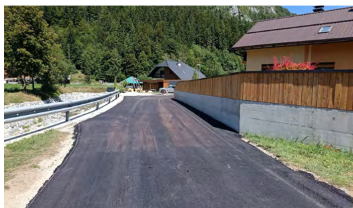
Sanacije ceste na Pristavi.
