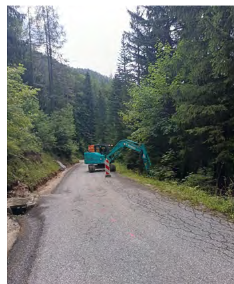
Nadaljuje se sanacija lokalne ceste v Podpeco v dolžini 1200 m.
