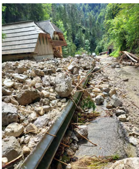
Rekonstrukcija ceste v Podpeco, območje po poplavih.
