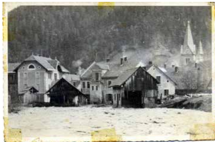
Pogled s Pristave na porušen hlev ob Kakerjevi hiši, danes Moličnikovi
