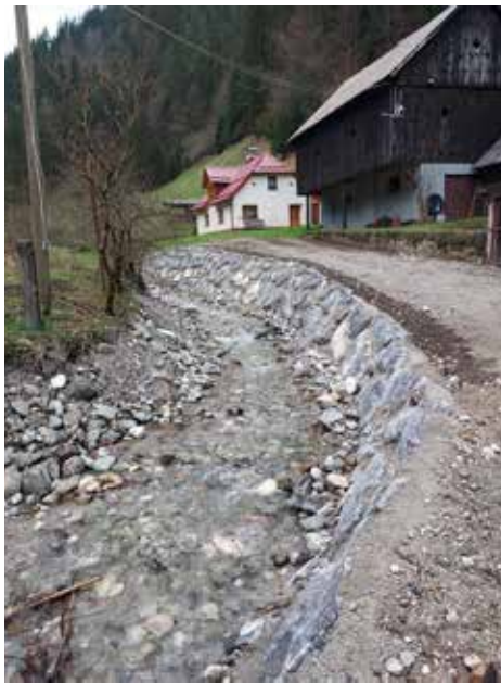
Urejanje struge potoka Janškov graben
