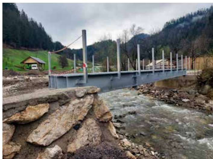
Postavitev mostu preko Javorskega potoka
