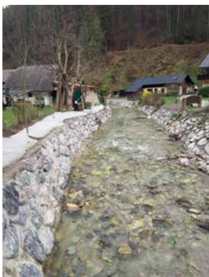
Ureditev struge in brežin, Jazbinski potok
