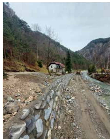
Urejanje reke Meže in izgradnja ceste v Žerjavu
