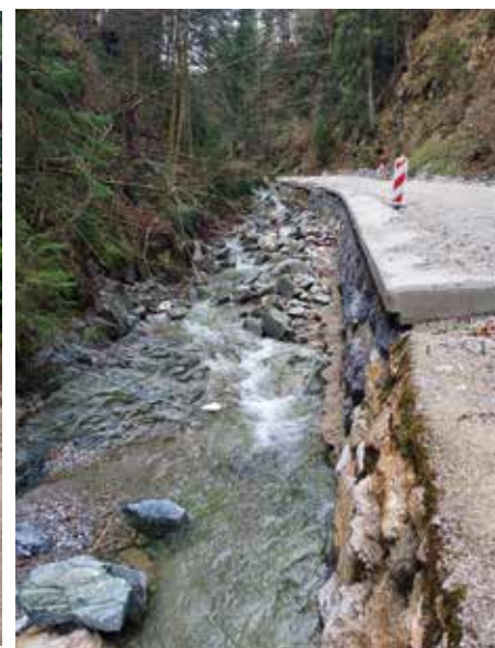
Urejanje struge reke Meže in ceste proti Koprivni
