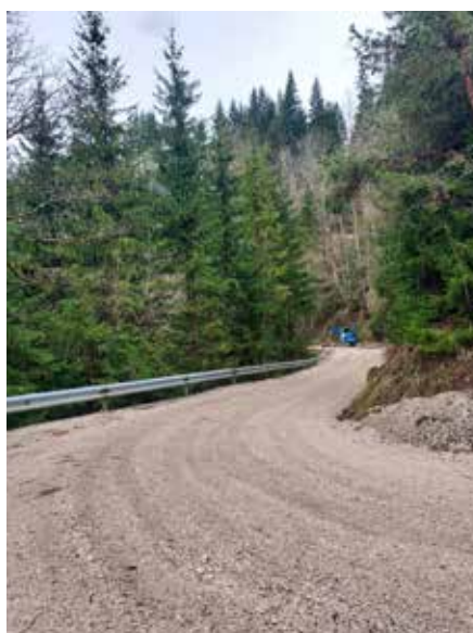
Začela se je sanacija lokalne ceste v Javorje v skupni dolžini 2500 m
