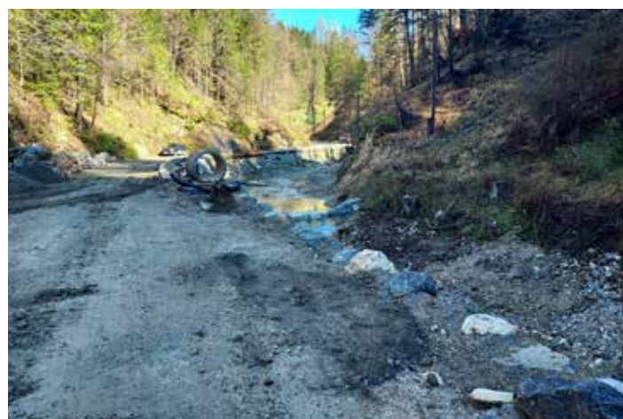
Nadaljujejo se sanacijska dela lokalne ceste v Podpeco
