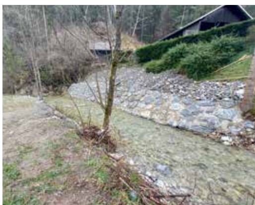
Ureditev struge in brežin, Jazbinski potok
