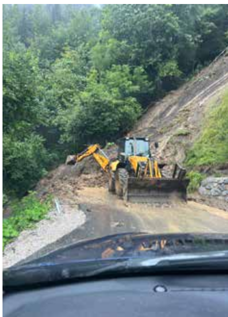
Odstranjevanje plazu pri Srebreči bajti. Strojnik Jure Voler
