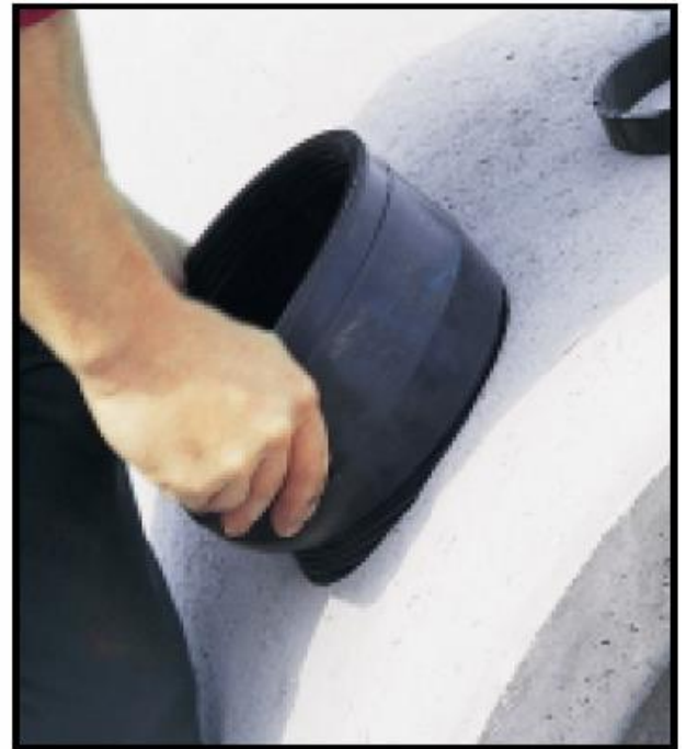
rechts: Einsetzen des Anschlussstutzens
